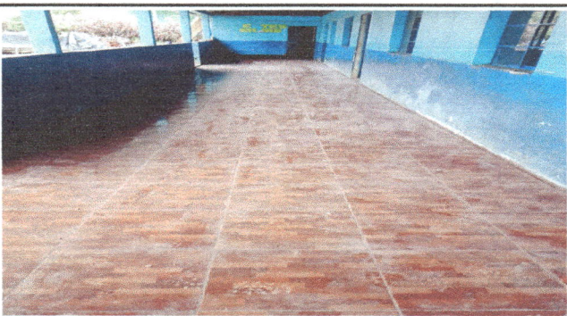
Foto 4: Colocacion de piso ceramico al corredor modulo 2
