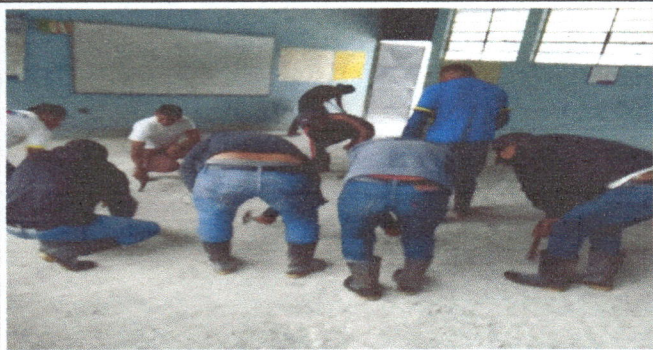
Foto1: Picar el piso de torca a ceramico (Modulo 2)
