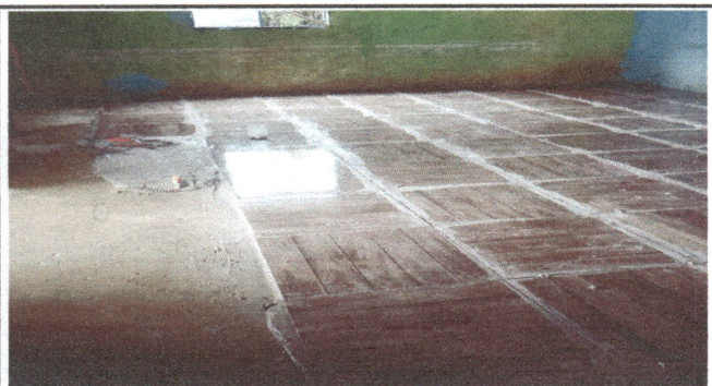
Foto 3: Colocacion de piso ceramico modulo 1
