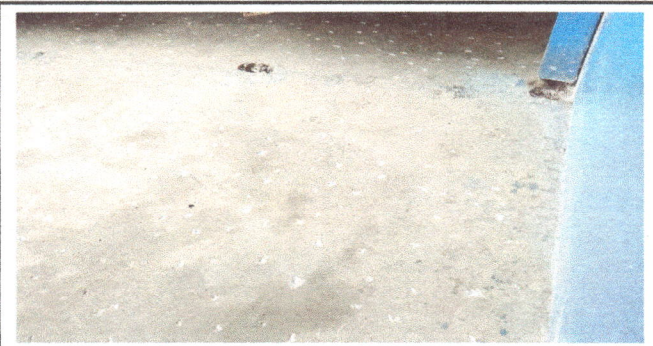
Foto 5: Picar el piso al interior modulo 2
